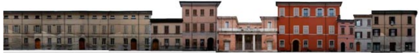
Figura 15a – Foto de exemplo do conjunto de edifícios da Via Chiaramonti
