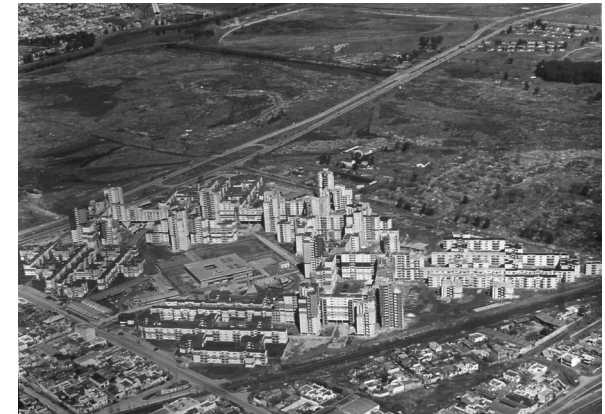
Figura 4 Vista aérea. “Conjunto Habitacional Soldati”. Fonte: acervo do Estudio STAFF 4 .
