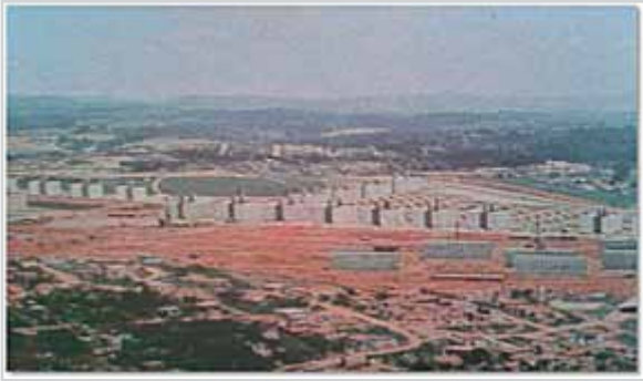
Figura 5. Construção dos Conjuntos Habitacionais em Itaquera. Fonte: PMSP (1979).
