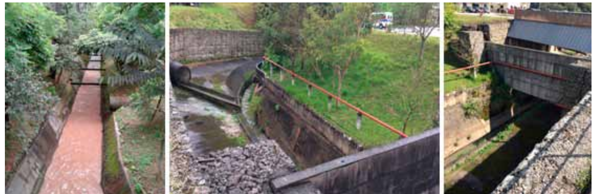
Figura 12. Córrego Chrysler - Dias atuais - vista canal retificado e reservatório contenção. Fonte: Acervo do autor, 2016.
