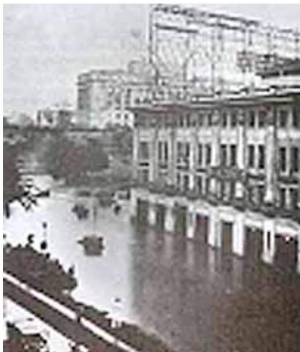
Figura 2. Inunda o do Vale do Anhangaba  – 1929. Fonte: PMSP/SVMA
