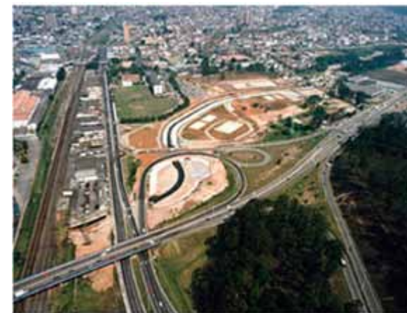
Figura 8. Reservatório de Mauá. Fonte: Revista PINI- Infra estrutura urbana, 2011.
