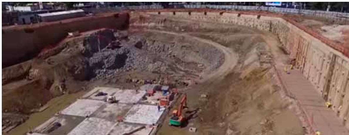
Figura 10. Imagem da construção do reservatório no Paço Municipal. Fonte: PMSBC-DRENAR -2016.
