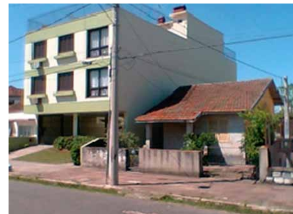
Figura 5. Transformação e descaracterização das edificações em tecidos tradicionais: Vila do IAPI/Porto Alegre. Fonte: SILVA (2010).
