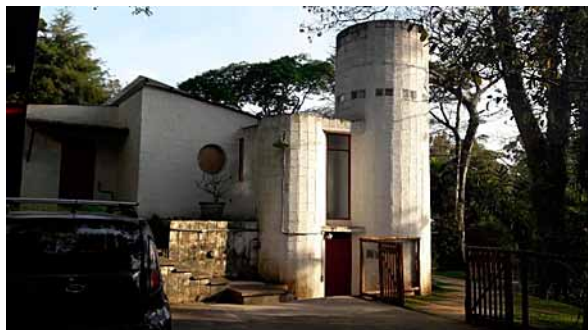
Figura 7. Lateral da construção desenvolvida a partir da “Casinha” original. Foto: Daniela Rosselli.
