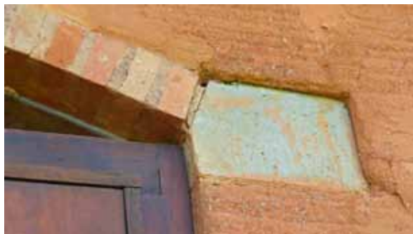
Figura 16. Detalhe das vergas das portas e janelas, executadas com tijolos comuns e reforço de concreto. Foto: Ricardo Carranza.
