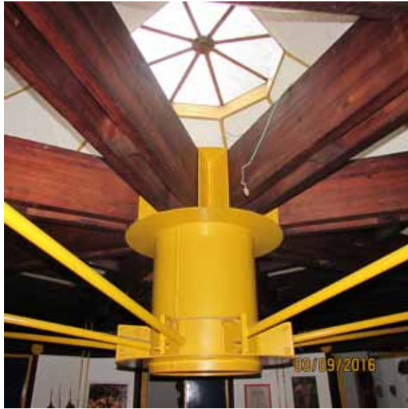
Figura 11. Peça articulada estrutural da cobertura. Foto: Daniela Rosselli.
