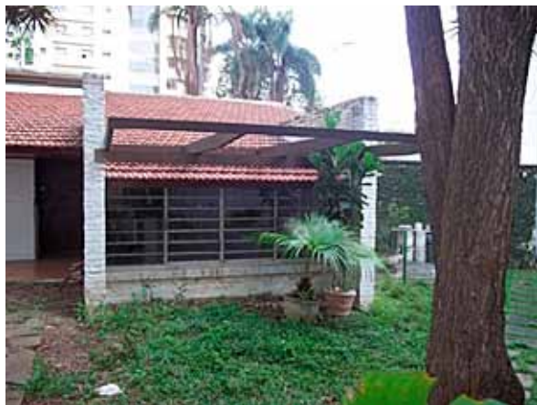
Figura 20. Casinha, residência de Vilanova Artigas, 1942. Detalhe do pergolado engastado na alvenaria portante de tijolos à vista. Foto: Edite Galote Rodrigues Carranza.
