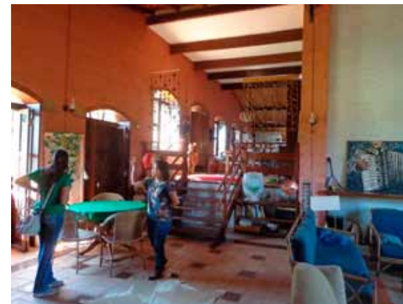
Figura 18. Vista da sala de estar em direção à sala de jantar e cozinha. Todos os ambientes integrados numa “sala praça”, como na Casa Bandeirista tradicional. No teto, a solução estrutural do piso superior com vigas de madeira e laje de concreto armado. Foto: Luis Octavio de Faria e Silva.
