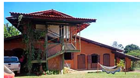
Figura 19. Vista lateral da Casa Gilda Barros. Em primeiro plano, a escada externa, modificação de projeto durante a construção. Foto: Luis Octavio de Faria e Silva.
