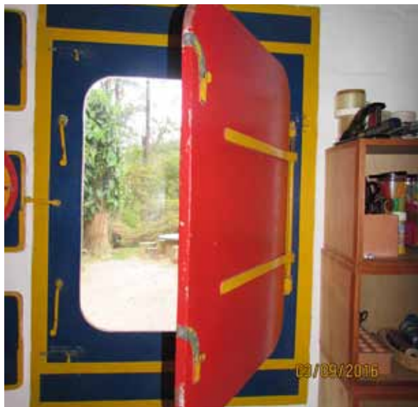
Figura 15. Uma das janelas vistas internamente, com gonzos para fechamento e pintada com cores primárias. Foto: Daniela Rosselli.
