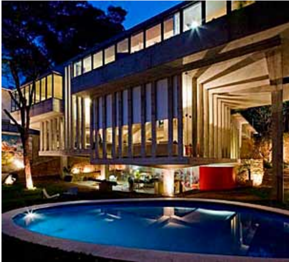
Figura 9. Casa João Marino, vista fachada Posterior. Fonte: http://www.au.pini.com.br/au/solucoes/galeria.aspx?gid=2914 . Acesso em: 31 mar. 2016.
