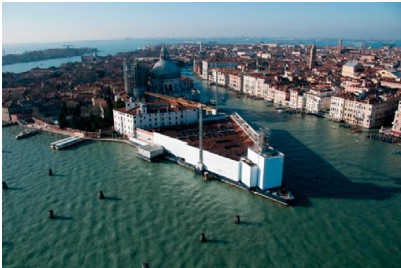
Figura 1 - Vista da Punta della Dogana com restauro em andamento. Foto de Ugo De Berti, cedida à autora por Dottor Group SPA, para publicação na revista arq.urb.
