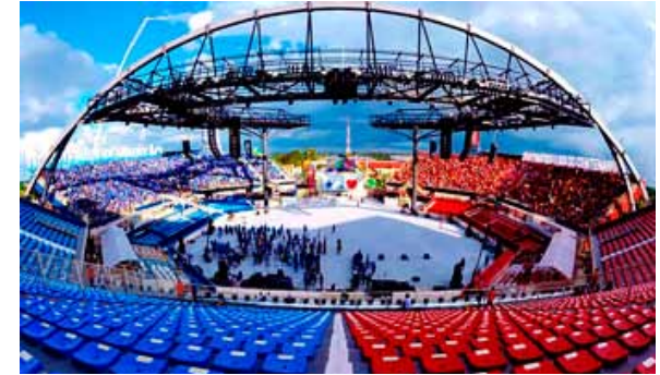
Figura 7. Estrutura executada. Fonte: http://engemetal.com.br
