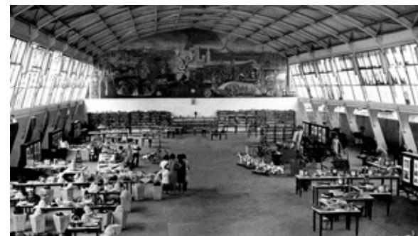
Figura 23. Foto interna do Pavilhão do Trabalho executado por Diógenes Rebouças. Fonte: http://www.cultura.ba.gov.br/wp-content/uploads/2014/10/Escola-Parque-baixa-resolu%C3%A7%C3%A3o.jpg . Acesso em 10/10/2015.
