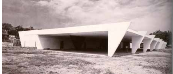
Figura 3. Ginásio de Itanhaém. João Vilanova Artigas e Carlos Cascaldi. 1959. Fonte: Biblioteca da FAU/USP.
