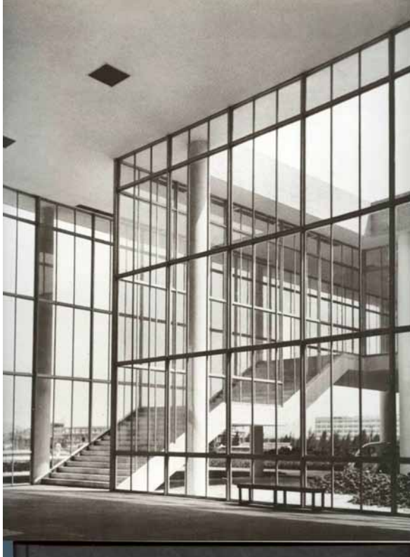
Figuras 5a (topo) e 5b (acima). Faculdade Nacional de Arquitetura. Jorge Machado Moreira. 1957. Fonte: Acervo da Universidade Federal do Rio de Janeiro.
