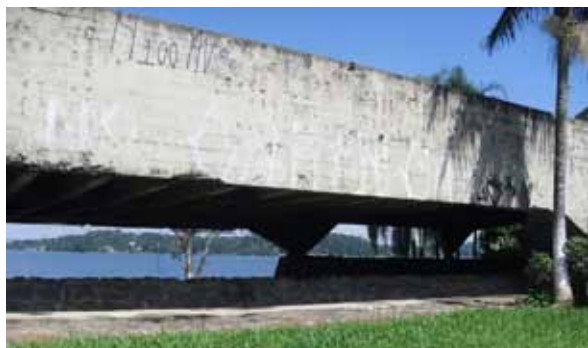
Figura 10. Permeabilidade e integração: o vazio do térreo da garagem de barcos permite a vista da represa, 2014. Fonte: Acervo do autor.
