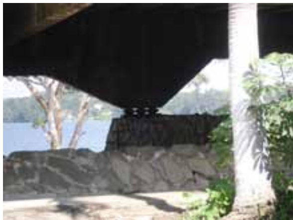
Figura 5. Vista dos celebrados apoios do pórtico sobre muro de pedra, 2014. Fonte: Acervo do autor.
