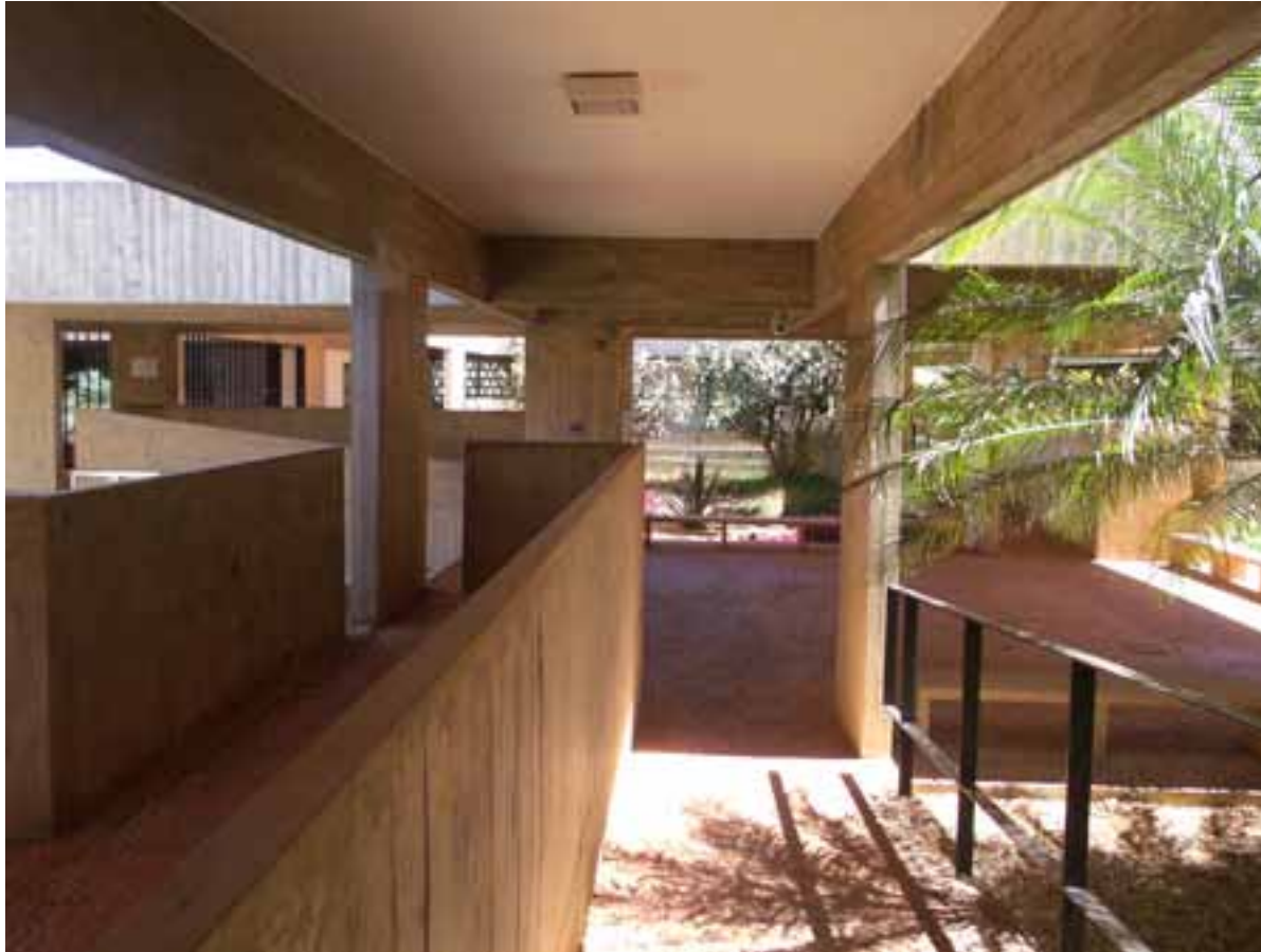
Figura 3: Interior da Chancelaria da atual Embaixada da França, em Brasília, projetada por Guillermo Jullian De La Fuente. Fonte: Fotografia da autora durante visita no dia 13 de agosto de 2015.
