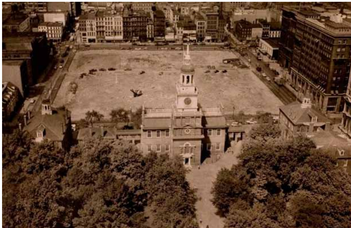
Figura 7. O Independence Mall em implantação. Demolição da primeira quadra, em meados de 1956. Fonte: GREIFF, 1987). Acesso 31 jul 2015.
