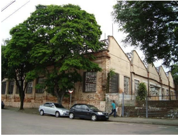
Figura 9. Vista da fachada frontal e lateral. Foto: José A.C.Zagato, 2011.
