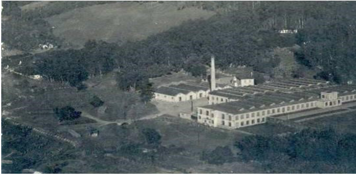
Figure 3. Aerial view Source: IGC (Instituto Geográfico e Cartográfico), 1939/1940.
