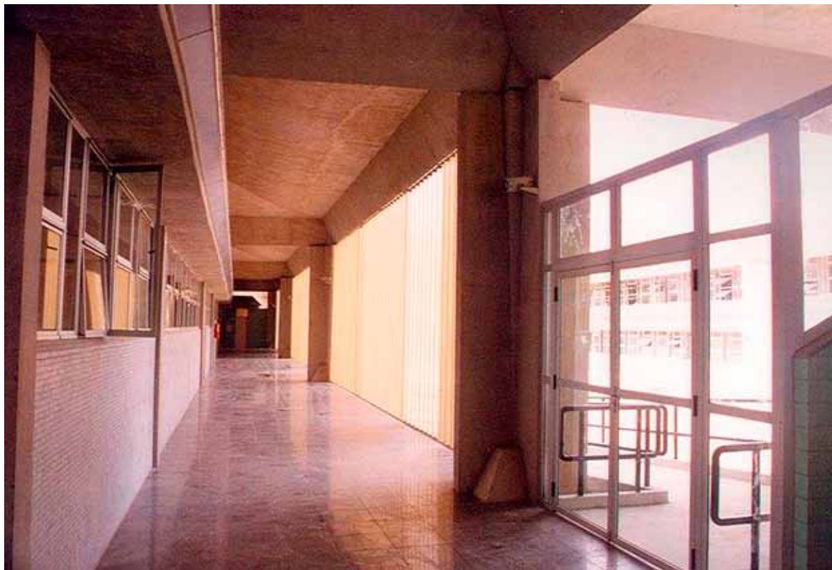
Figura 19. À esquerda, circulação da Suframa após a reforma de 1994. Os brises móveis que cobrem todo o vão foram instalados em apenas em algumas circulações por conta do custo. No projeto da década de 1970 o projeto também previa brises em todas as circulações. Foto: Acervo Pessoal do Arquiteto Severiano Porto.
