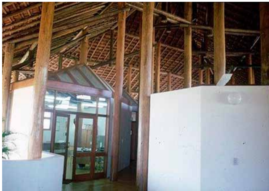
Figura 12 e 13. À esquerda, notar os espaços fechados independentes da cobertura e a riqueza dos detalhes construtivos do Centro de Proteção Ambiental de Balbina...
