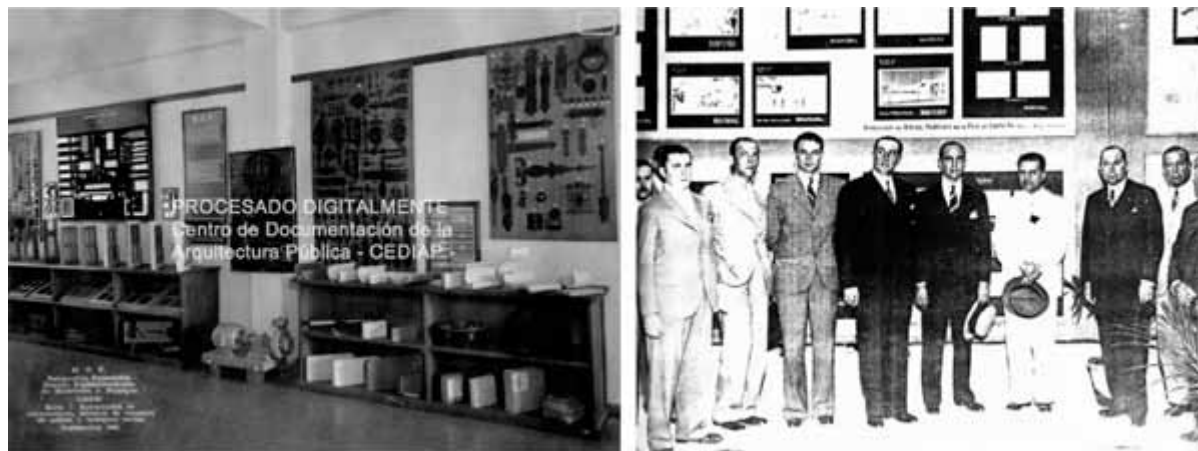
Figura 1. Exposición de materiales del Ministerio de Obras Públicas de la Nación, Buenos Aires 1941. Fuente: CEDIAP. Delegados de la Dirección de Obras Públicas de la Provincia de Santa Fe en el Vº Congreso Panamericano de Arquitectos, frente a stand premiado (1940). Fuente: Boletín DOPP, año 1, nº1, mayo de 1940.
