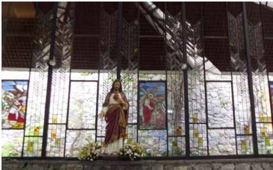
Figura 24 – Fotografia do interior (set/2012). Parede de pedra da Sacristia construída posteriormente e fora das especificações do projeto original. Fonte: FGVR.
