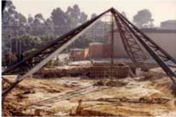
Figura 04 d – Fotografia da montagem da estrutura (jul/1985). A estrutura e a escavação. Fonte: arquivo do escritório Shieh Arquitetos Associados.
