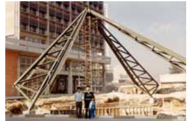
Figura 04 c – Fotografia da montagem da estrutura (jul/1985). Os arquitetos Maria Zarría U. Dubena e Shieh Shueh Yau, com seu filho Leonardo, frente à estrutura. Fonte: arquivo do escritório Shieh Arquitetos Associados.
