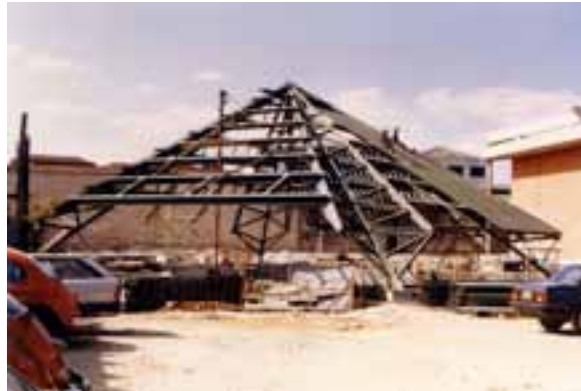
Figura 04 f – Fotografia da montagem da estrutura (ago/1985). Colocação das vigas secundárias e da fôrma metálica de sustentação do preenchimento de concreto celular. Fonte: arquivo do escritório Shieh Arquitetos Associados.
