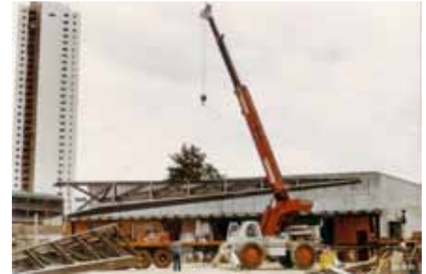
Figura 04 a – Fotografia da montagem da estrutura (jul/1985). Guindaste levantando a primeira viga. Fonte: arquivo do escritório Shieh Arquitetos Associados.
