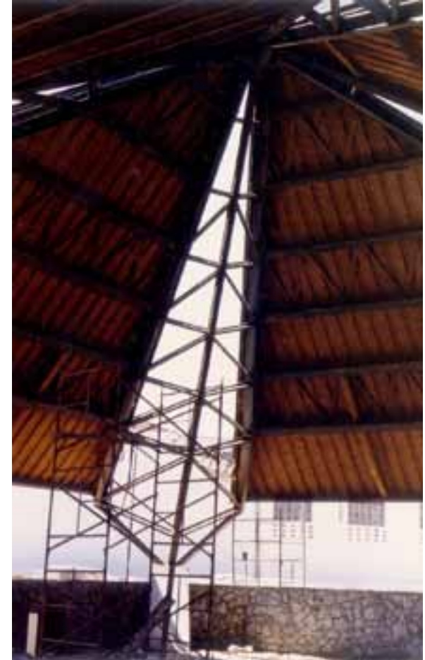
Figura 04 g – Fotografia da montagem da estrutura (ago/1985). A estrutura desde o interior. Fonte: arquivo do escritório Shieh Arquitetos Associados.
