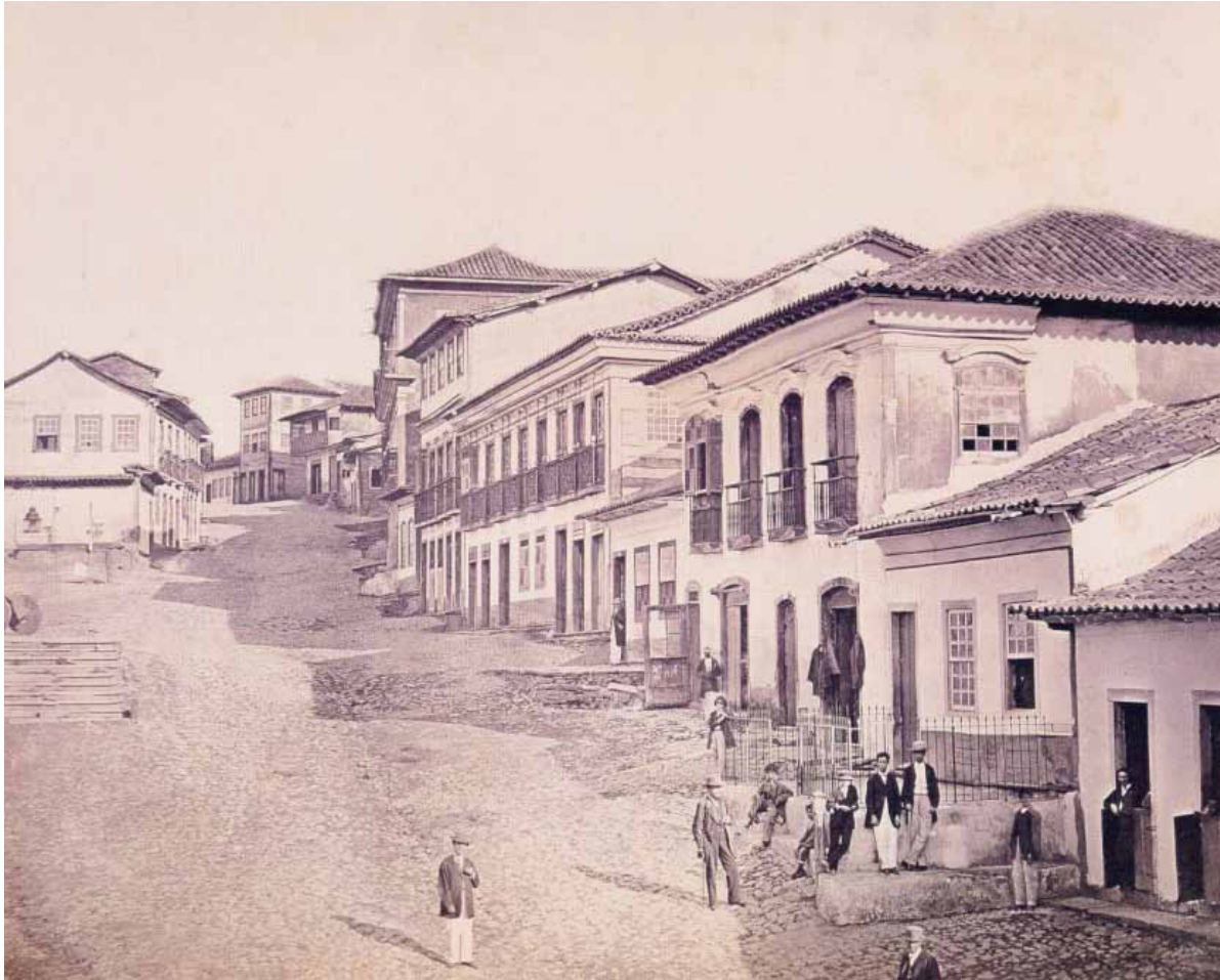
Figura 9: Rua Direita, fotografada por Augusto Riedel (ca. 1868). Fonte: Lago (2005).
