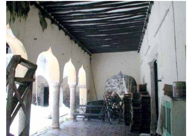
Figura 9. Columnas de tambor en la Capilla de San José en Espita, Yucatán. Fuente: A. Román.
