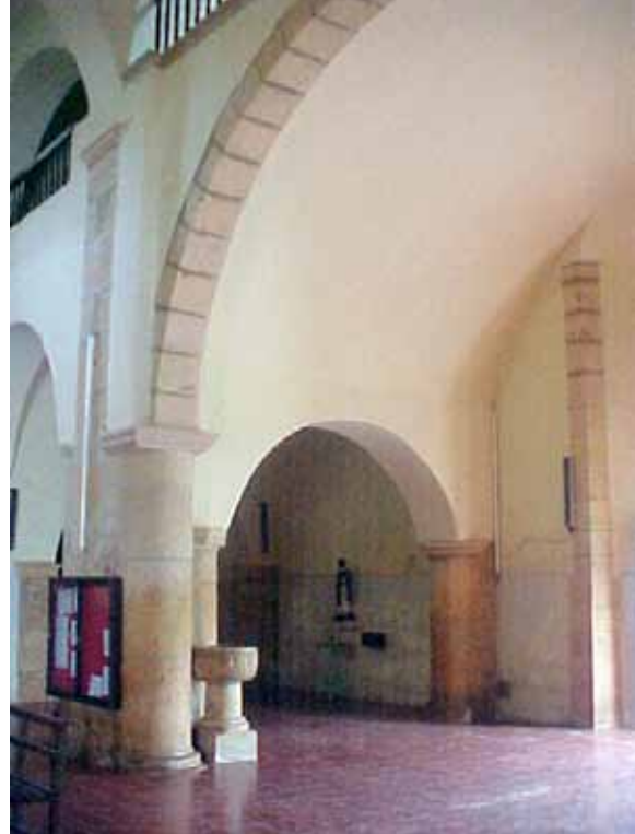
Figura 10. Arco dovelado en el soto coro de la iglesia conventual de San Juan Bautista en Tekax, Yucatán. Fuente: A. Román.
