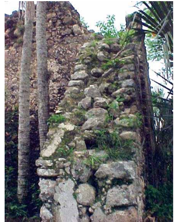
Figura 7. Mampostería aparejada e hiladas rigidizantes en los muros de la Capilla de Santa Isabel, Ticuch, Yucatán. Fuente: A. Román.
