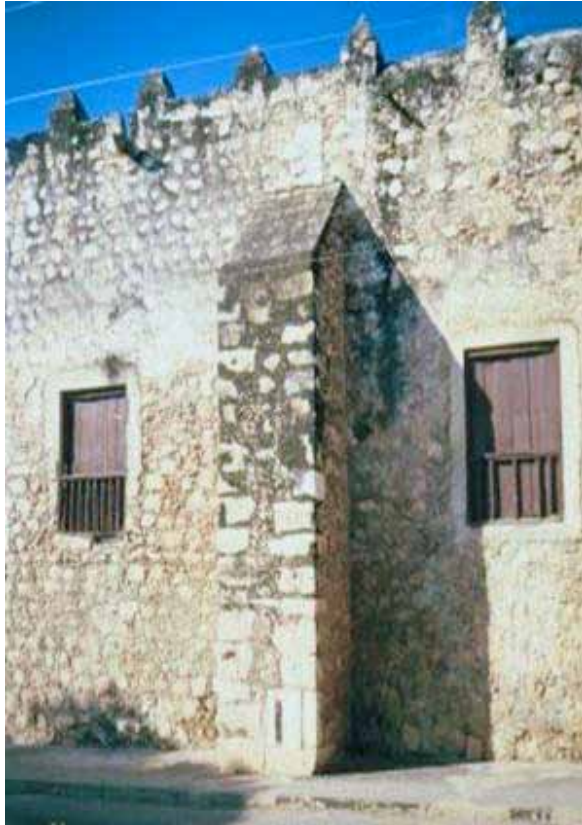
Figura 8. Contrafuertes de mampostería en el convento de La Asunción en Muna, Yucatán. Fuente: A. Román.
