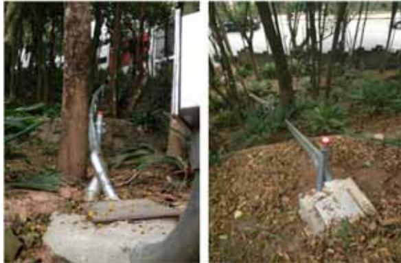
Figuras 3 e 4. Tubulação nova de envelopamento das instalações elétricas, lógica e telefonia, projetada de modo a não afetar as raízes das árvores no entorno da casa.
