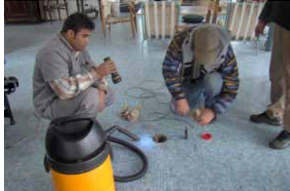
Figura 5. Substituição da fiação nos tubos internos da casa. Foi necessário um trabalho especial para a reutilização dos tubos existentes, sem a sua substituição. Funcionário do Instituto (com a lanterna) acompanha o serviço terceirizado.
