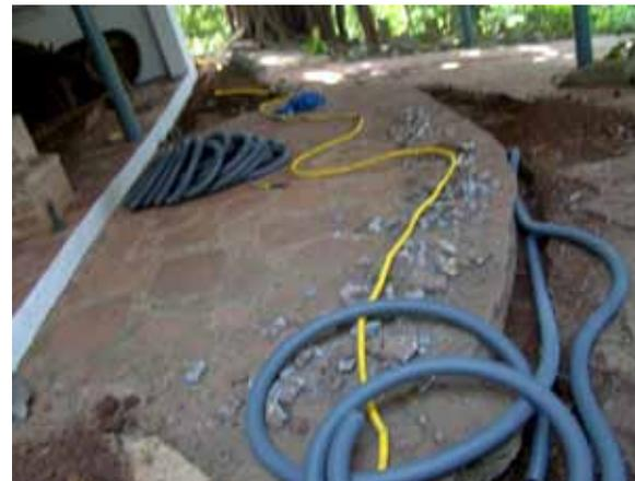
Figura 6. Instalação de nova tubulação para a rede elétrica na área sob os pilotis, sem danificar o piso existente.
