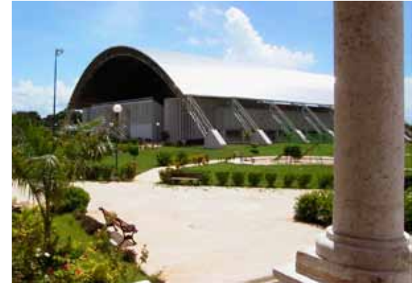
Figura 18. Conjunto Deportivo "La Inalámbrica en Mérida", Yucatán. Fuente: autores.
