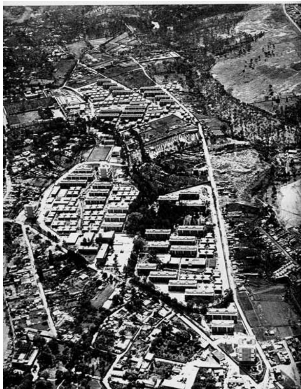
Figura 14. Vista aérea de la UI. Fuente: IMSS.
