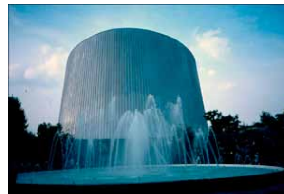
Figura 5. Conjunto Alfa en Monterrey. Fuente: autores.
