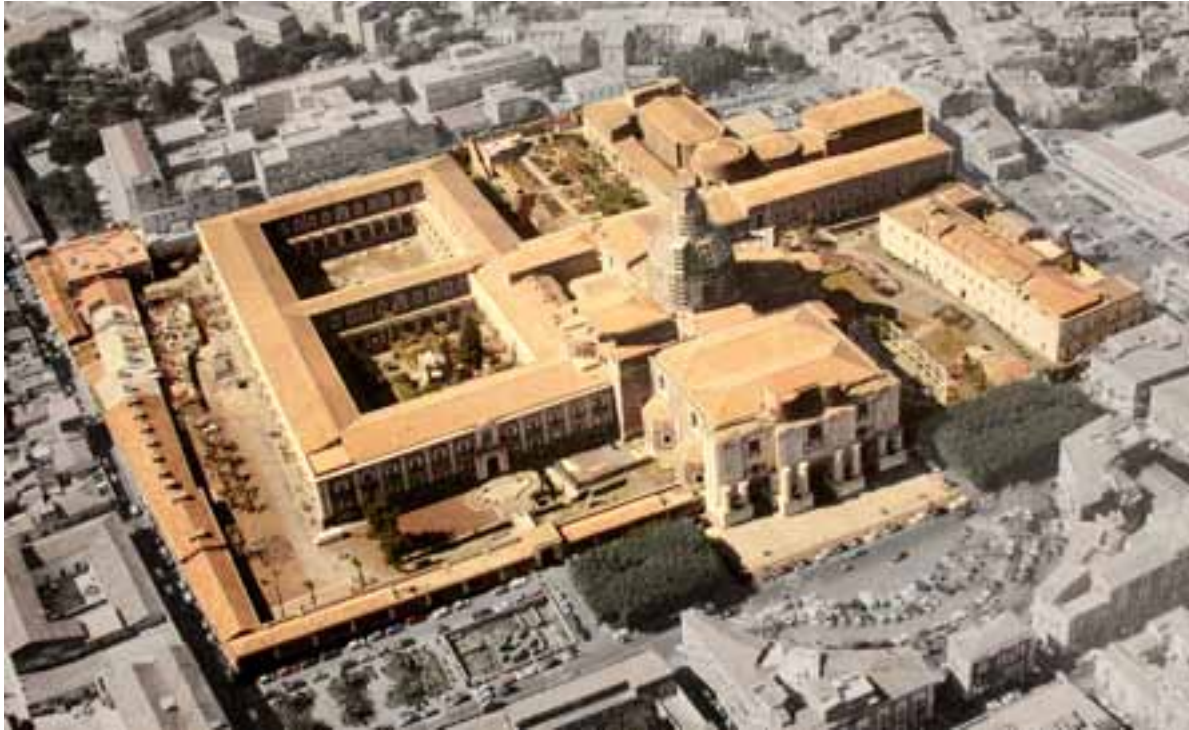
Figura 1 - Vista aérea do conjunto do antigo Mosteiro Beneditino, hoje sede da Universidade de Letras e Filosofia de Catania. Fonte: http://catania.livesicilia.it/2013/01/24/dal-rea-le-al-virtuale-monastero-hi-tech_221383/ . Acesso: 02/06/14.
