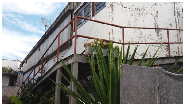
Figura 9. Rampa de acesso à edificação da Câmara Municipal de Coronel Vivida - PR. Fonte: Acervo da(s) Autor(as).
