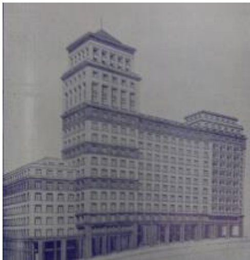
Figura 3: Perspectiva do Edifício do SULACAP/Porto Alegre. Fonte: Revista Notícias do Sulacap, ano 6, maio de 1942, número 69.
