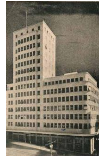
Figura 4: Edifício Sul América/Porto Alegre. Fonte: Disponível em: https://lista.mercadolivre.com.br . Acesso em: 16 mar. 2020.
