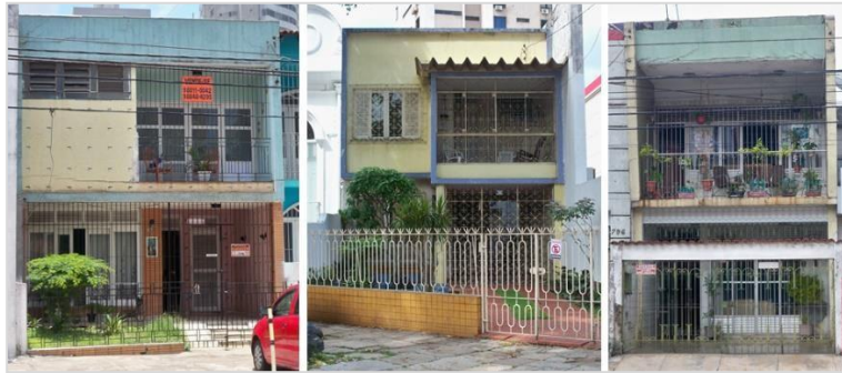
Figura 10: Casas modernistas e os revestimentos de forma regular na fachada. Fonte: Rodrigo de Lima(2018)
