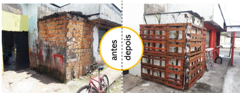
Figura 7: Fachada de restaurante localizada na esquina da entrada principal do centro comercial do Conjunto Jardim Maguari – antes e depois da intervenção urbana. Fonte: Acervo dos autores.
