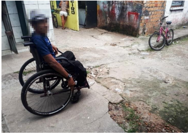
Figura 4: Condição física do calçamento da circulação principal do centro comercial do Conjunto Jardim Maguari. Fonte: Acervo dos autores.
