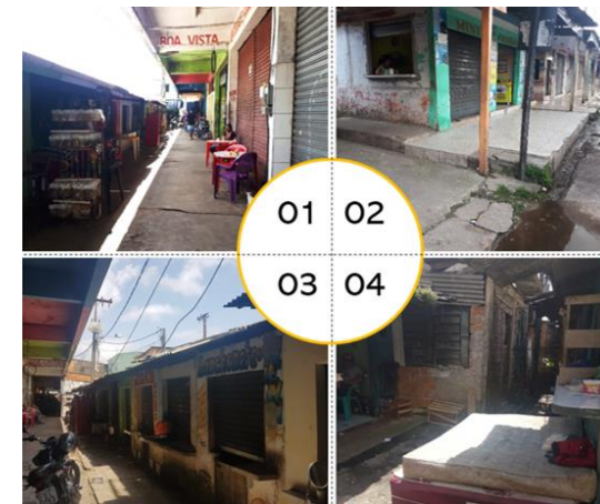
Figura 2: Instalações físicas em linha temporal: 01) primeiros boxes comerciais; 02) Primeira ocupação irregular; 03) Última ocupação irregular; 04) Espaços residuais decorrentes da última ocupação irregular. Fonte: Acervo dos autores.
