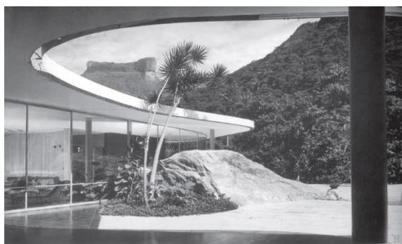
Figura 10. Varanda da residência mostrando a borda com face em chapa metálica. Fonte: Habitat, set. 1954.
