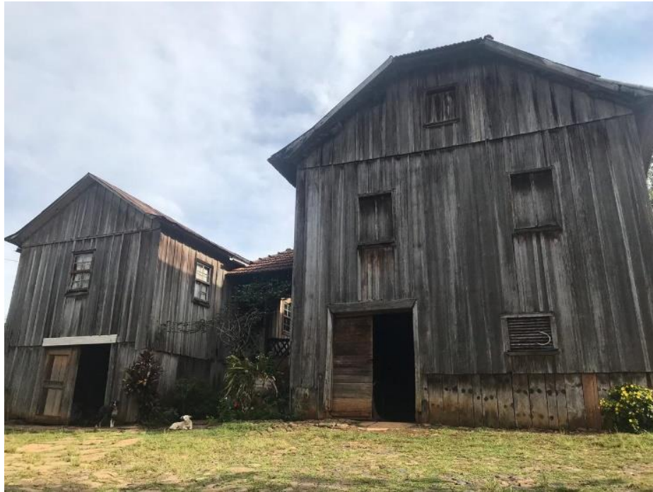
Figura 6: Residência edificada por volta de 1905. Fonte: Autores, 2020.
