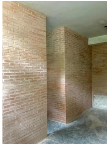
Figura 4 – Parede construída com blocos de terra comprimida, produzidos na Ocupação 'Solano Trindade', Movimento Nacional de Luta pela Moradia (MNLN), Duque de Caxias, RJ. Imagem dos autores
