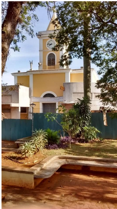
Figura 5: Vista para a fachada da paróquia (em obras de ampliação), onde é possível observar que a vegetação e arborização são elementos presentes. O sombreamento se percebe abundante no espaço. Fonte: Acervo do(s) Autor(es).
