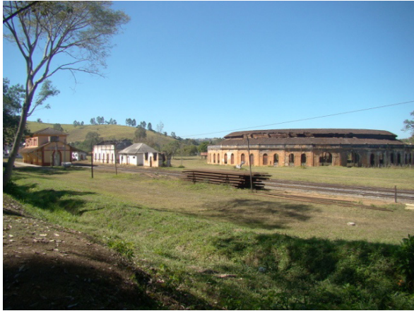
Figura 1 – Vista panorâmica do Complexo Ferroviário de Ribeirão Vermelho. Fonte: VELOSO, 2015.
