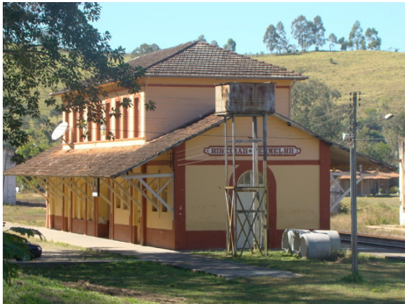
Figura 2 – Vista do edifício sede da Estação de Ribeirão Vermelho. Fonte: VELOSO, 2015.
