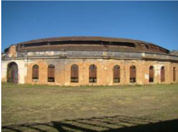
Figura 3 – Vista externa da rotunda. Fonte: Fonte: VELOSO, 2015.
