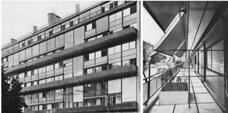
Figura 15 – Immeuble Clarté (1930), Genebra, Suíça. O que parece, ser elementos opacos e irregulares na fachada são, de fato, as persianas rolôs. À direita vemos as cortinas rolôs oblíquas. Fonte: LE CORBUSIER & JEANNERET, 1935.
