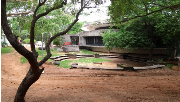
Figura 26. Galeria de arte Kala Kendra, edifício originalmente pensado para abrigar um restaurante. Foto do autor.
