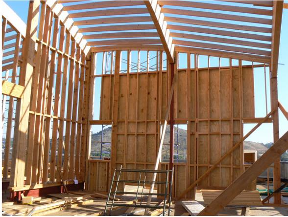
Figura 8. Etapas de montagem da vedação em Wood fame - edifício 3555 Hayden. Fonte: foto dos autores.
