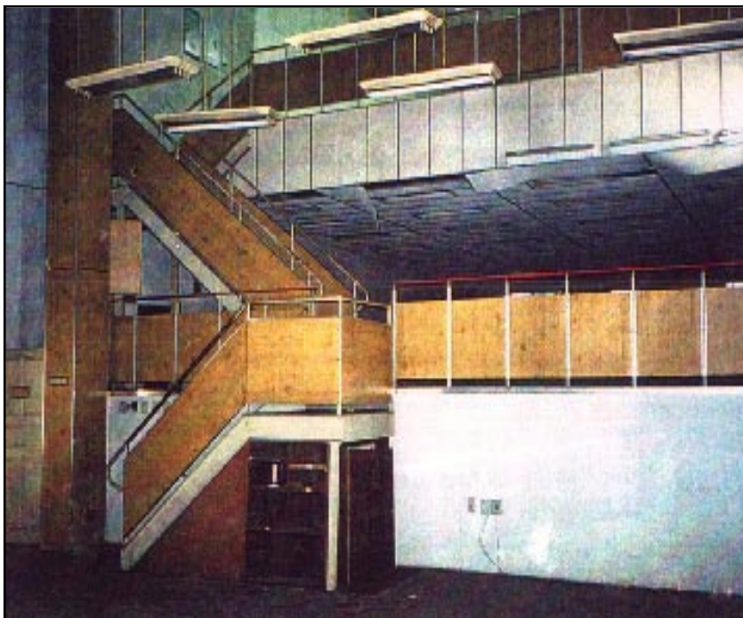
Figura 12 - Mezanino metálico não original construído pela CEEE. Em seu lugar foi construído o auditório Barbosa Lessa. A estrutura metálica do mezanino foi reaproveitada para fazer a laje inclinada do auditório e foyer. Sob a laje nova estão os camarins, serviços e instalações técnicas. Foto: Beto Rodrigues.
