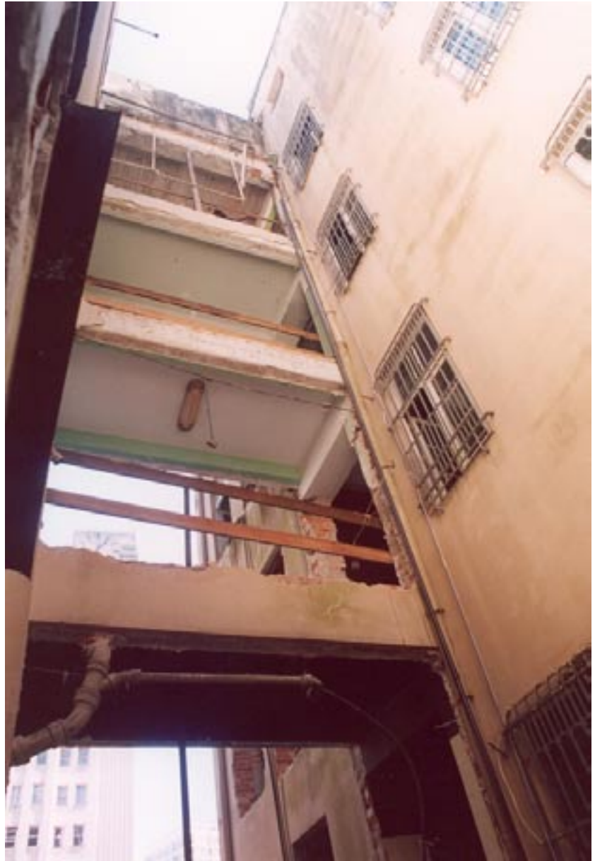
Figura 6 - Antigos poços de ventilação e iluminação durante as obras de demolição das paredes. Foto: Beto Rodrigues
