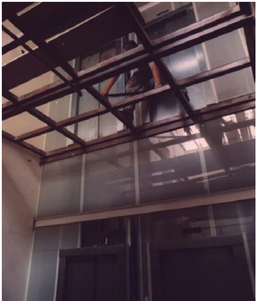
Figura 8 - Transformação de um dos poços de ventilação e iluminação em circulação vertical mecânica. Montagem das divisórias, piso e forro de vidro do hall dos elevadores. Foto: Beto Rodrigues
