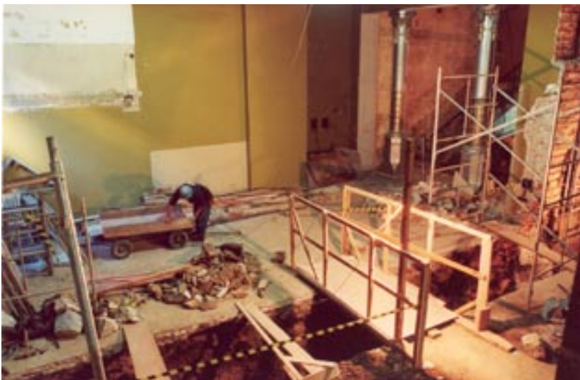
Figura 5 – Vista do térreo durante as obras. Abertura de um túnel de fuga para a nova escada de incêndio externa. Foto: Beto Rodrigues
