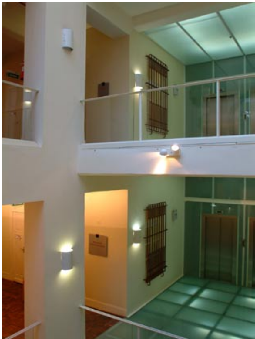
Figura 10 – Os novos elevadores passaram a ocupar um dos antigos poços de ventilação e iluminação. As antigas janelas da escada permaneceram, recebendo tratamento anti-fogo. Foto: Del Re + Stein
