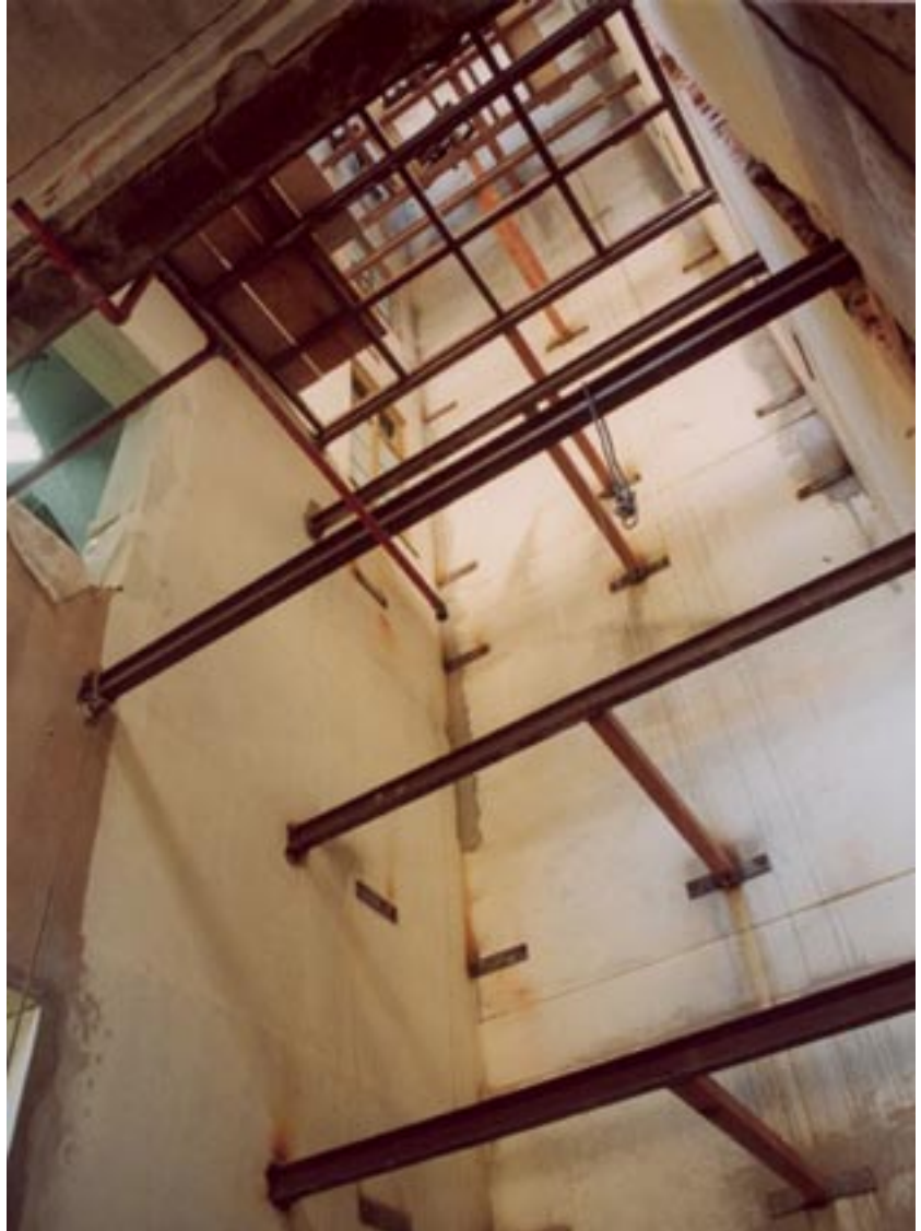
Figura 7 - Fixação da estrutura metálica de suporte dos pisos e formação da caixa de corrida dos novos elevadores. Foto: Beto Rodrigues
