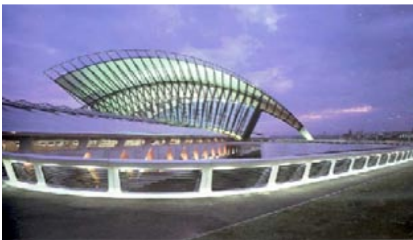
Figura 1 - Vista geral Estação Lion
