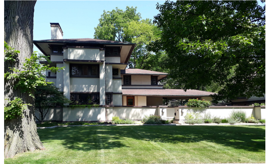
Figura 3. Frank Lloyd Wright. Casa William E. Martin, 1903, Oak Park. Fonte: Foto Rodrigo Queiroz.
