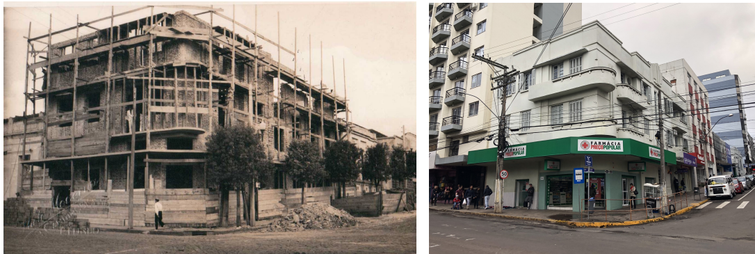
Figura 4. Edifício Lângaro em sua construção no ano de 1942. À esquerda o edifício em construção, projetado segundo uma estética Art Déco pelo arquiteto Annito Petry. À direita o edifício na atualidade. Fonte: Acervo Fernando Canali Lângaro e autores, 2018.
