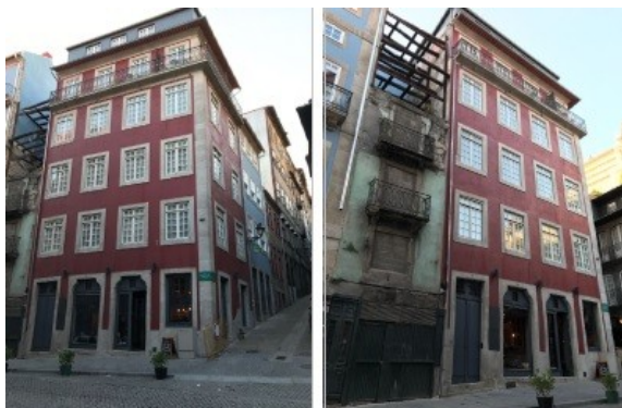
Figura 01 - Vistas da edificação escolhida em Porto. Fonte: Arquivo Pessoal do autor, 2017
