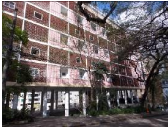
Figura 1. Foto do edifício Caledônia no Parque Guinle exemplificando as possibilidades plásticas geradas pela separação entre estrutura e vedação. Fonte: Acervo do(s) Autor(es).
