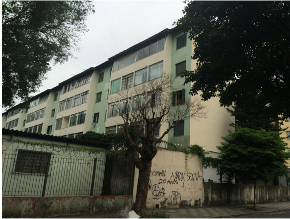
Figure 1. The Mooca Housing Complex, 2016. Source: Flávia Brito do Nascimento.
