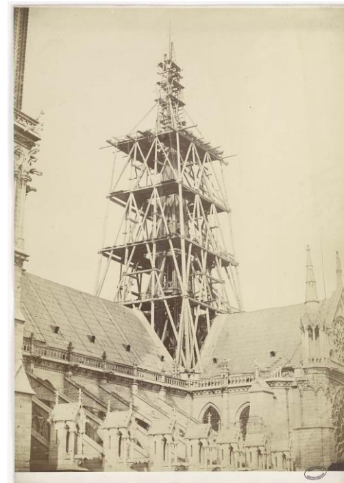
Figura 6. Catedral de Notre Dame com a flecha em construção em fotografia de Bissons Frères, 1857. Fonte: Ministère de la Culture (France), Médiathèque de l'architecture et du patrimoine, diffusion RMN-GP . Domínio público
