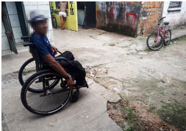
Figura 4: Condição física do calçamento da circulação principal do centro comercial do Conjunto Jardim Maguari. Fonte: Acervo dos autores.
