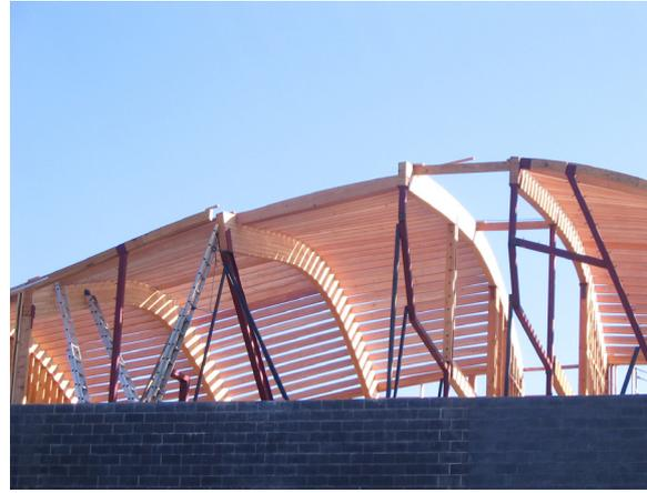
Figura 9. Montagem cobertura arcos laminados – edifício 3555 Hayden -. Fonte: foto dos autores.
