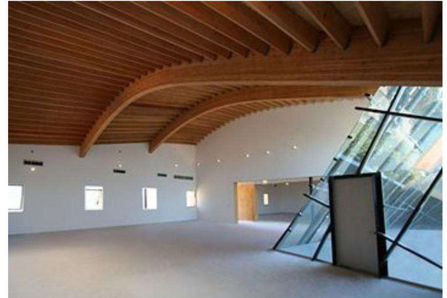
Figura 12. Vista interna viga em madeira laminada e esquadrias - edifício 3555 Hayden. Fonte: ERIC OWEN MOSS ARCHITECT.
