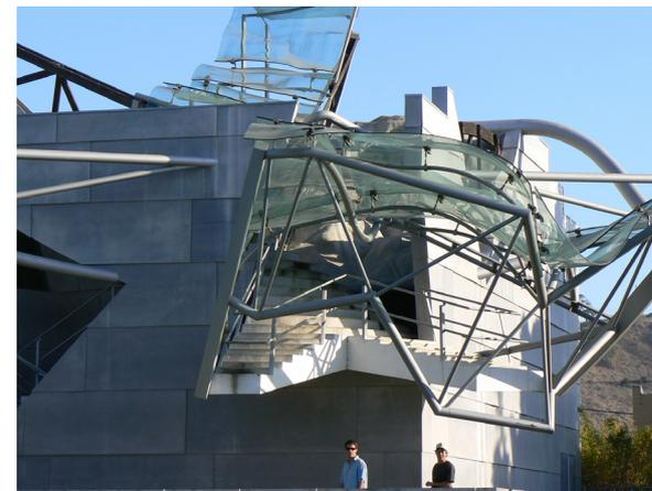
Figura 4. Treliça em balanço na entrada do Edifício Umbrella - Conjuntive Point Culver City Fonte: foto dos autores
