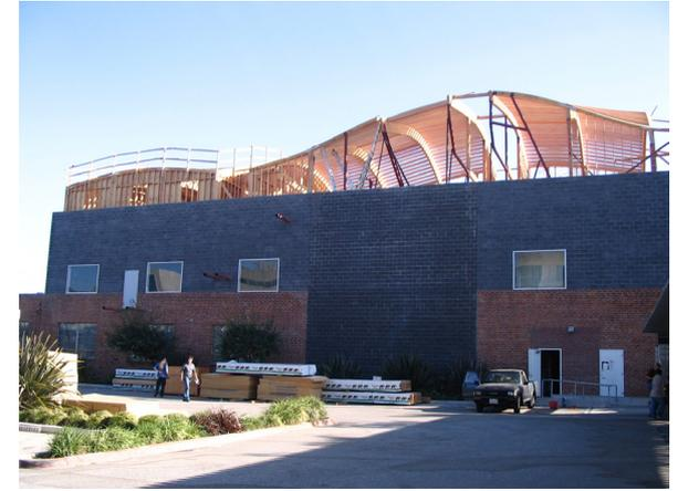
Figura 10. Vista externa da estrutura da vedação e cobertura curva - edifício 3555 Hayden. Fonte: foto dos autores.
